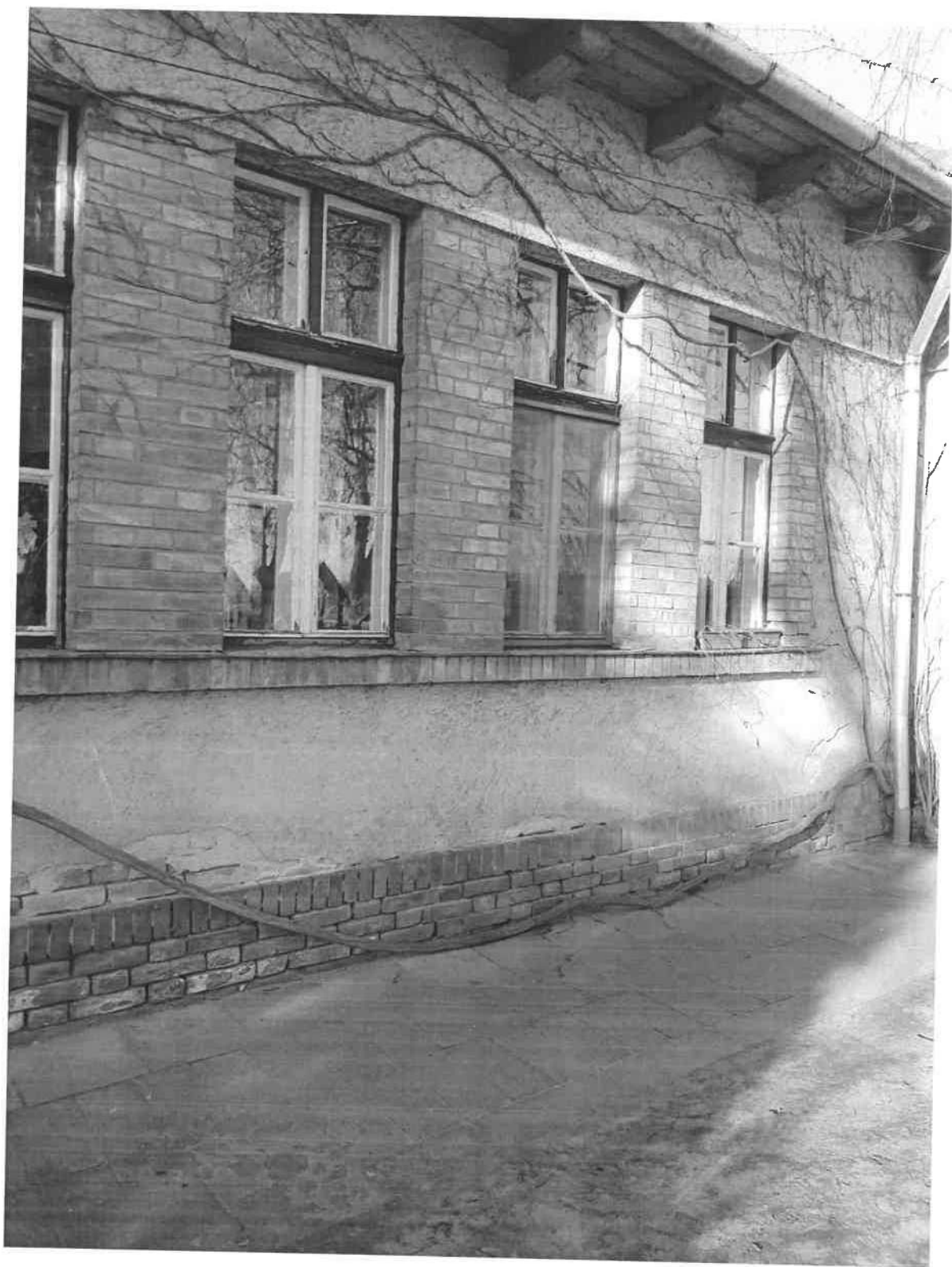
Eredeti iskolaépület ablakai. Ma már a felső ablakok csavarral vannak rögzítve.
