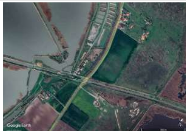
Sándorfalvi út – Algyői főcsatorna (Fehértói csatorna) keresztezésében fekvő tanyák (lakóépületek)
