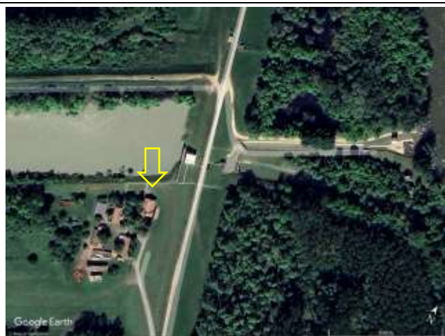
Algyői szivattyútelephez tartozó szivattyúház (Algyő 01257/2 hrsz. - lakóépület)
