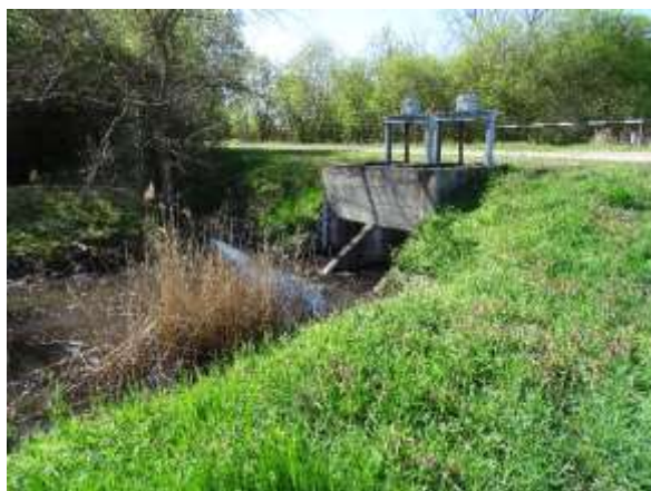
A Szillér-Baktó-Fertői főcsatorna erősen benőtt medre a 4+850 szelvényében
